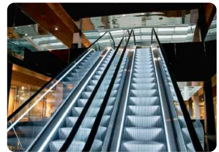
Éclairage LED main courante ou plinthe
